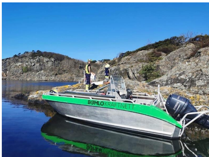
Arbeid med montasje av farvasskilt
